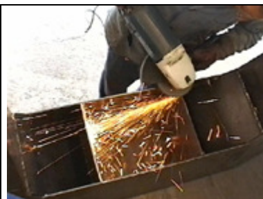
Abschleifen mit Winkelschleifer Die inneren Aussteifungsrippen sind bei noch fehlendem Deckblech hier sichtbar
